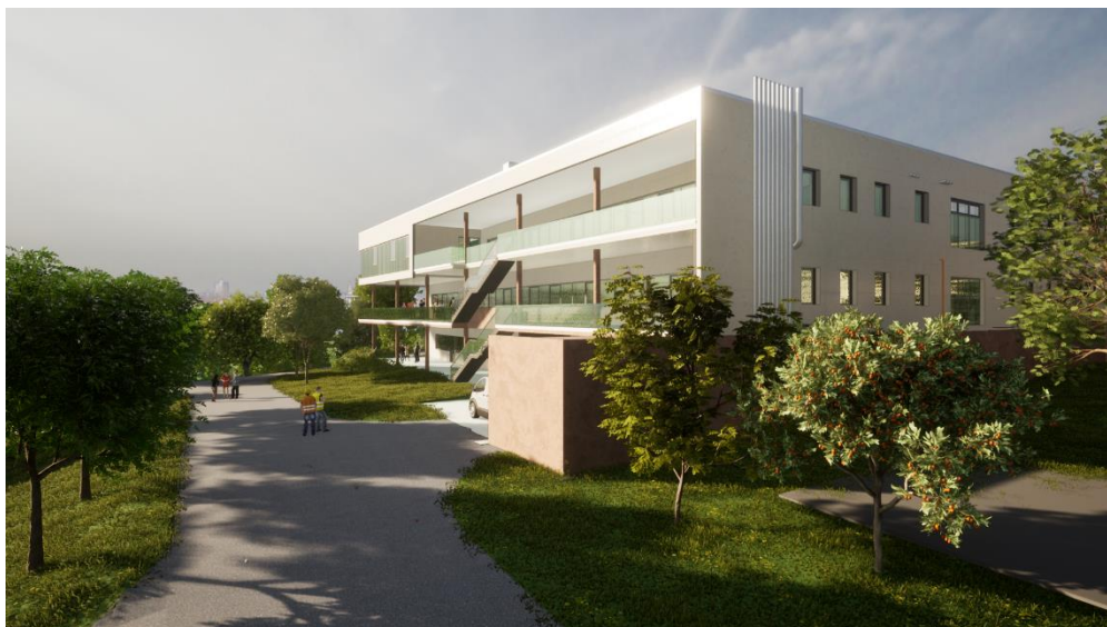
Slika 11. Pristupa suterenskoj etaži
